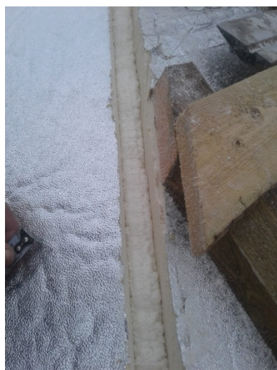
Рисунок 5 - Укладка PIR-плит в коньке крыши
