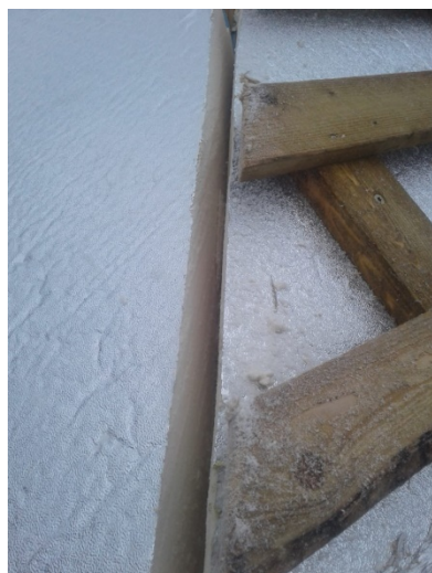
Рисунок 5 - Укладка PIR-плит в коньке крыши
