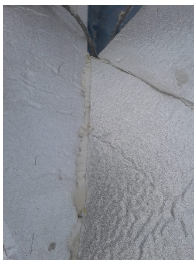
Рисунок 6 - Укладка PIR-плит в зоне ендовы
