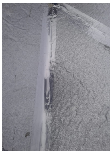
Рисунок 6 - Укладка PIR-плит в зоне ендовы
