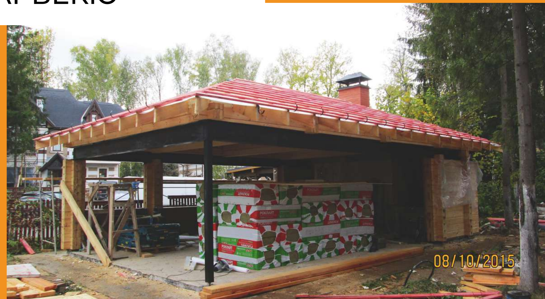
УТЕПЛЕНИЕ КРОВЛИ ТЕРРАСЫ ЗОНА БАРБЕКЮ
